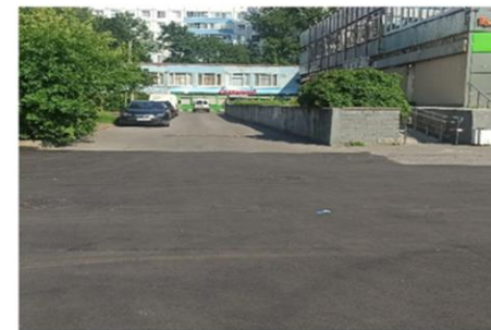
ЯМОЧНЫЙ РЕМОНТ ВНУТРИКВАРТАЛЬНЫХ ПРОЕЗДОВ
