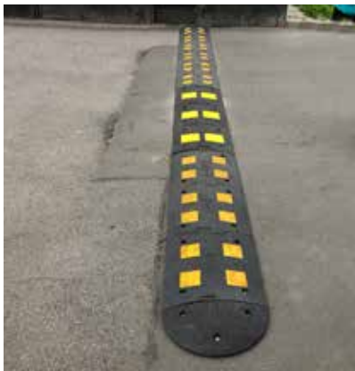
ул. Авангардная, 20, – установка «лежачего полицейского»
