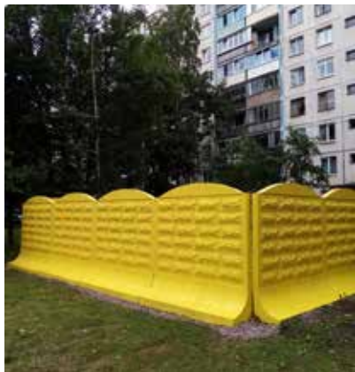
ул. Партизана Германа, 28, корп. 2, – установка ограждения контейнерной площадки
