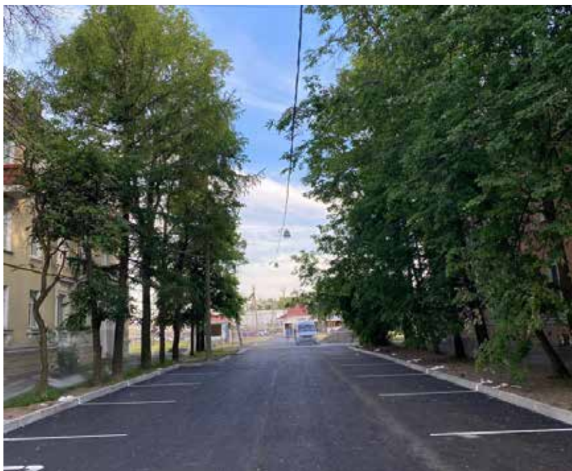
пр. Народного Ополчения, 211, 213, – ремонт и уширение проезда
